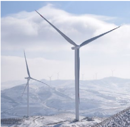
丰宁大区风电场项目风机
