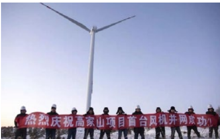
高家山项目风机并网成功现场
