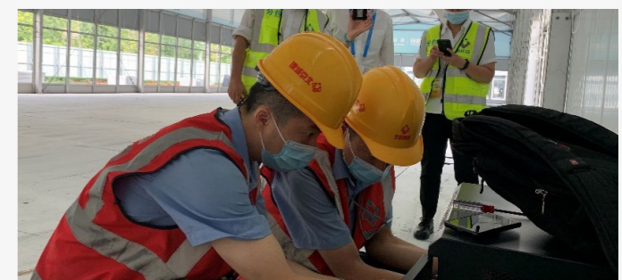
室外场馆设备安装调试
