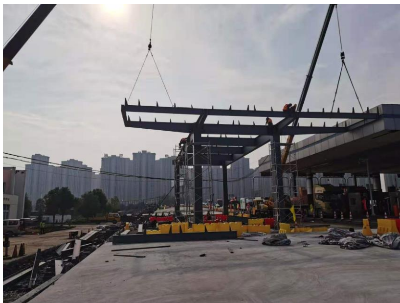
合肥绕城高速蜀山收费站增加 3 个入口车道和 1 个出口车道，拓宽后为 7 进 7 出车道
