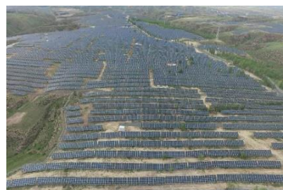
晶澳山西大同 50MW 光伏电站
