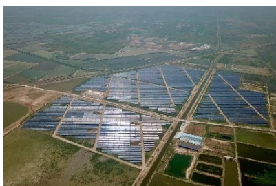
晶澳宁夏贺兰 30MW 光伏电站
