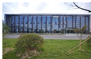
扬州基地 BIPV 项目
