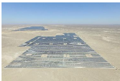
晶澳新疆和丰 30MW 光伏电站
