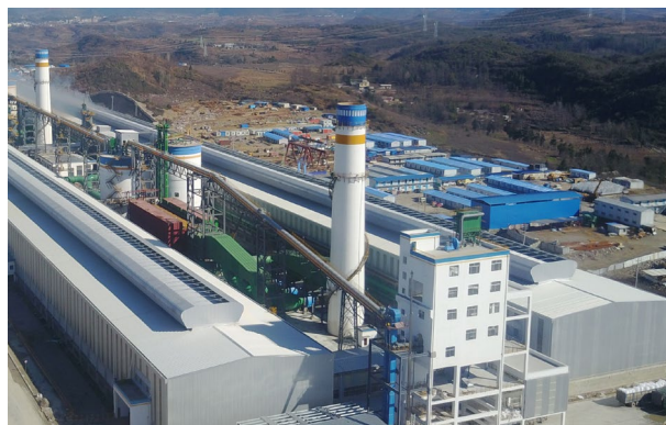
500kA 大型预焙电解槽工程——贵州华仁项目 Guizhou Huaren large-scale pre-baked electrolytic cell project
