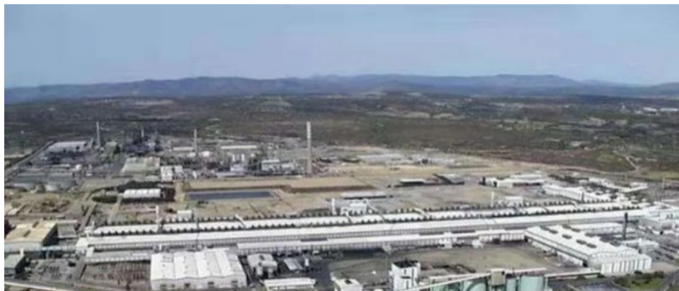
意大利维斯梅电解铝改造项目 Electrolytic Aluminum Reconstruction Project in Italy
