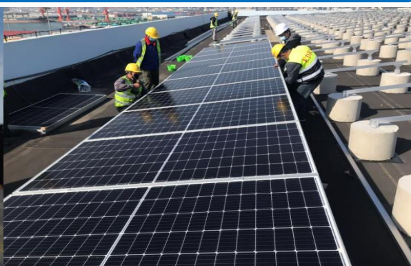
冷库库顶安装光伏发电设施
