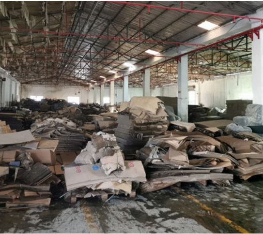
广东省某企业因暴雨导致车间及仓库进水，造成设备大面积受损
