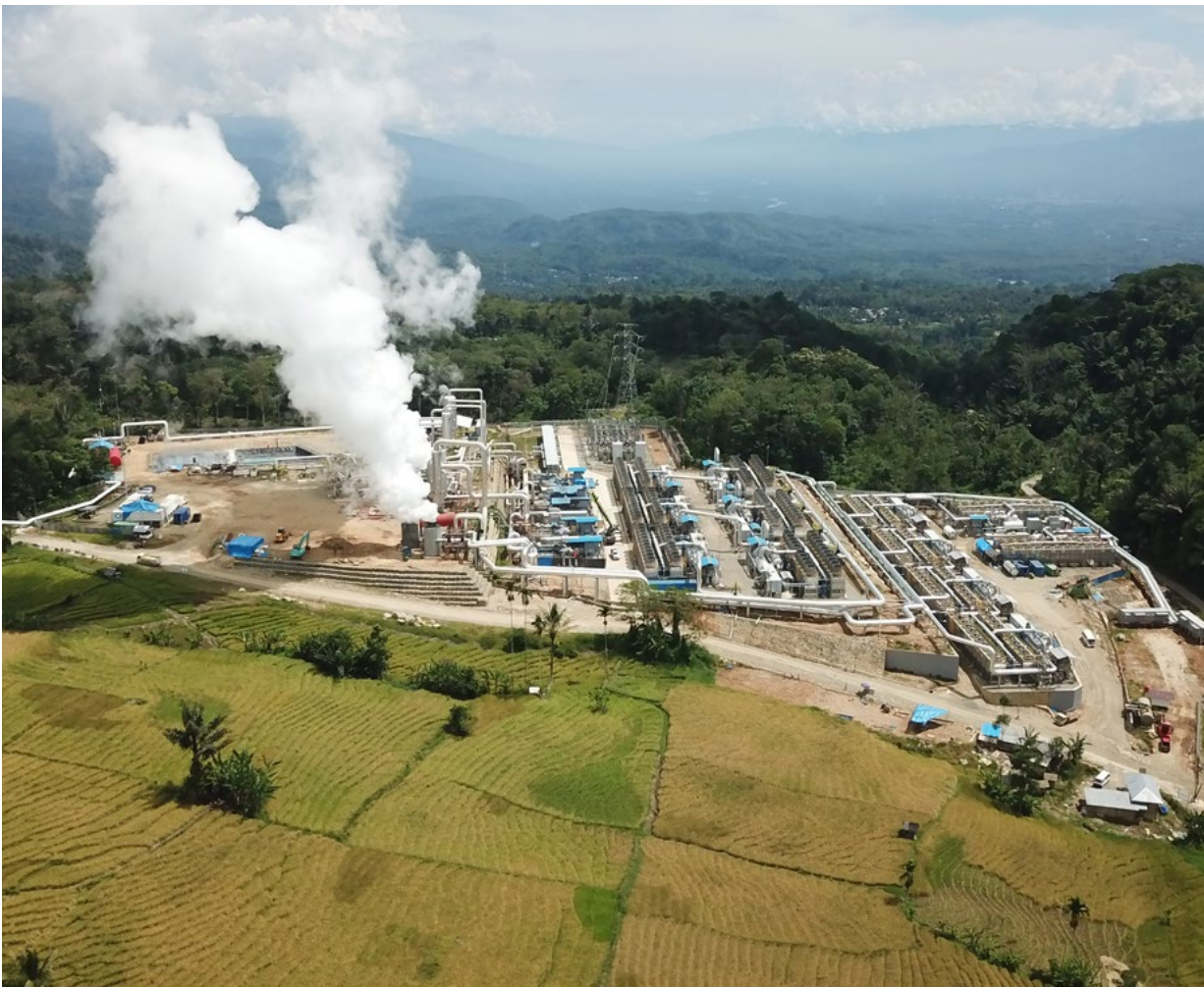
中行浙江省分行支持的印尼地热项目一期现场
