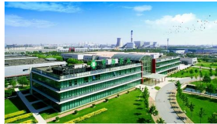
中新药业现代中药产业园
