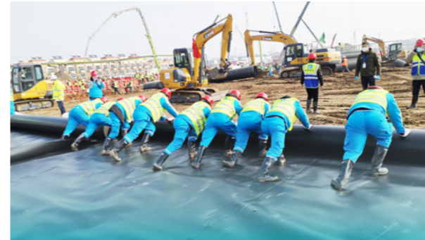
高能环境应急施工团队驰援武汉火神山医院建设
