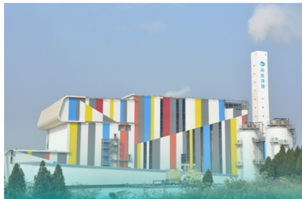
荆门生活垃圾焚烧发电项目
