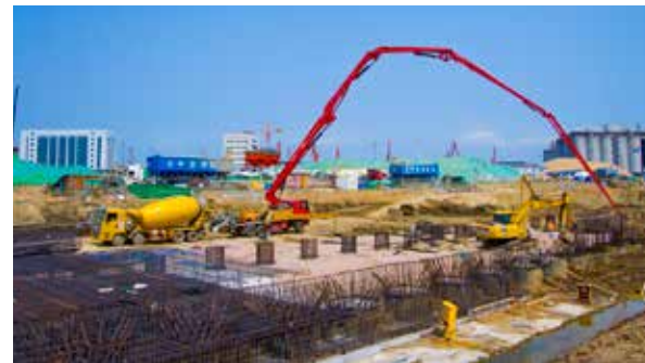
▲ 南沙粮食及通用码头扩建工程
