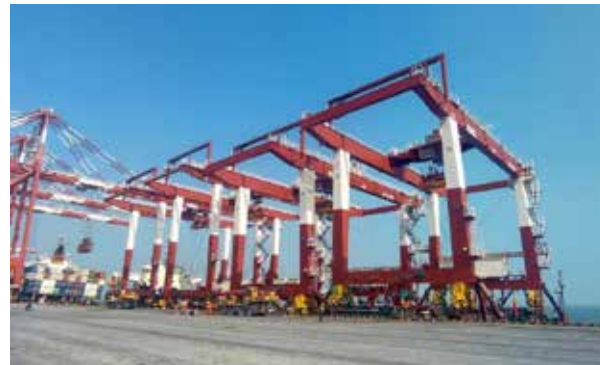
▲ 南沙三期半自动化堆场一期工程 项目配套的所有设备全部到位
