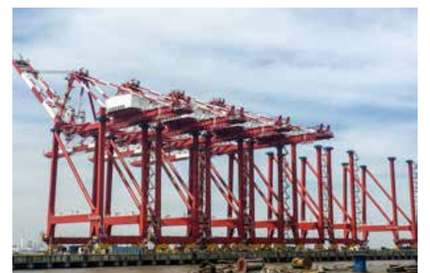
▲ 南沙四期自动化装卸设备自动化单小车岸桥顺利通电试车
