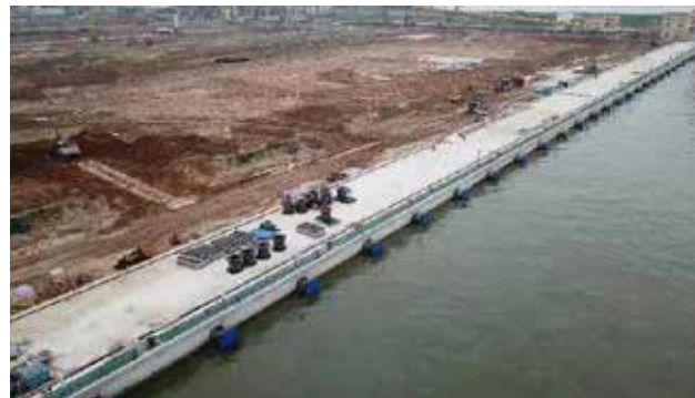
▲ 广州港新沙港区二期工程完成 11 号、12 号通用泊位水工主体结构施工
