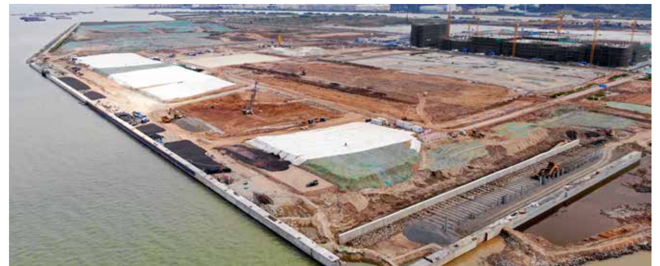
▲ 近洋码头码头主体结构完工
