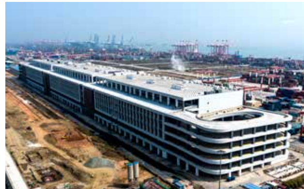
▲ 广州南沙国际物流中心（北区）工程主体结构封顶
