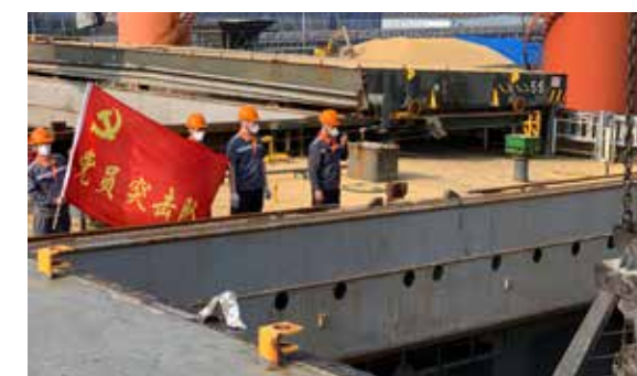
▲ 新沙公司装卸大豆船现场
