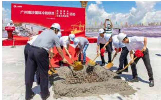
▲ 广州南沙国际物流中心（南区）一期工程封顶
