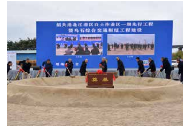
▲ 韶关港北江港区白土作业区一期工程动工
