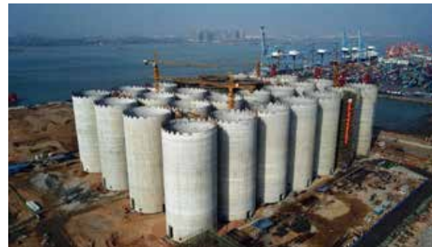
▲ 新沙 11#、12# 泊位工程完成粮食筒仓滑模主体结构施工
