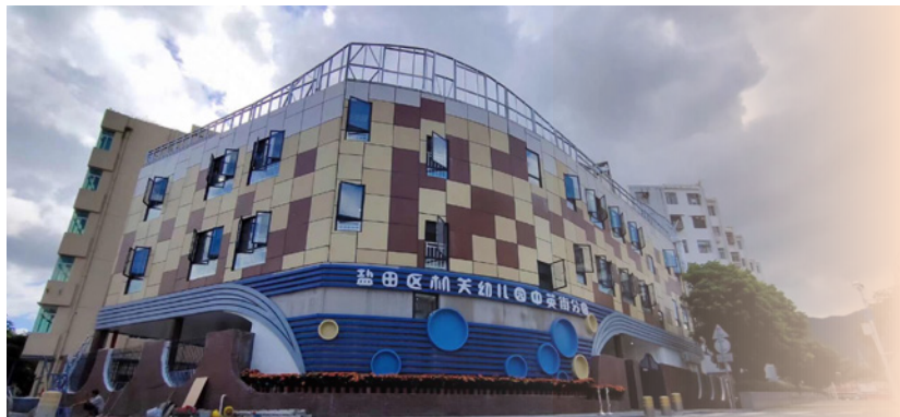
盐田区机关幼儿园中英街分园(原盐田区沙头角镇幼儿园)拆除重建工程
