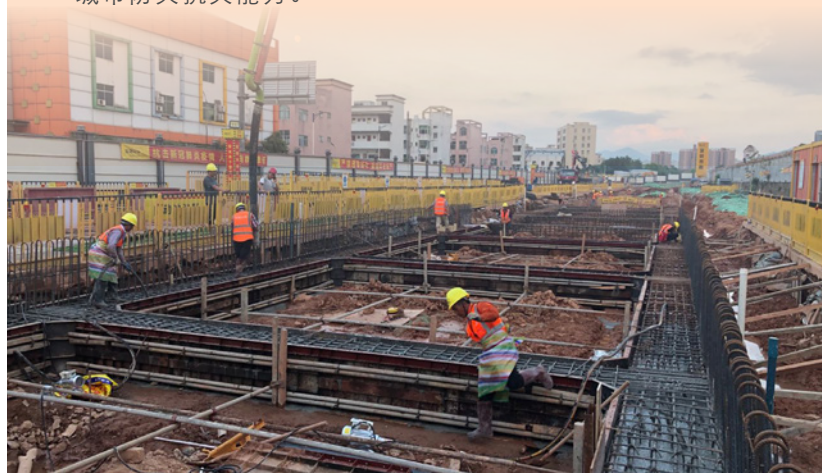
○ 坪山区金辉路综合管廊工程
