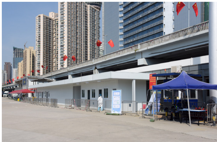
○ 深圳市文锦渡口岸防疫应急工程
