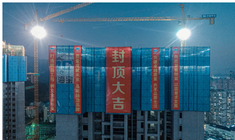
○ 布心片区04地块完成A、B号塔楼主体结构封顶
