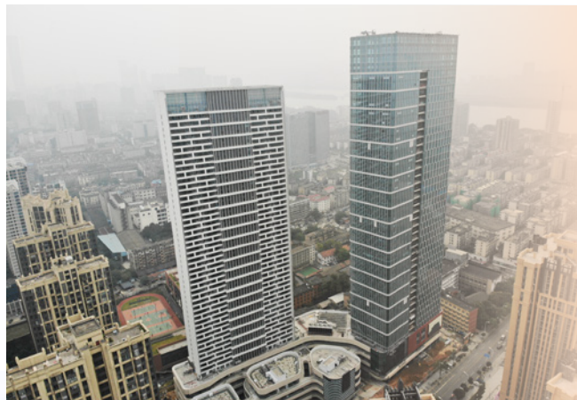
○ 长沙天健芙蓉盛世花园三期项目南区
