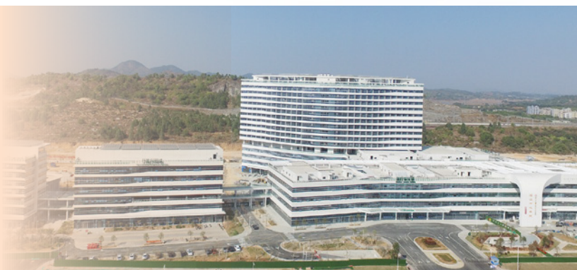
深汕中心医院项目配套工程
