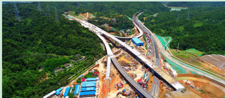
○ 东部过境高速梧桐立交段装配式市政工程
