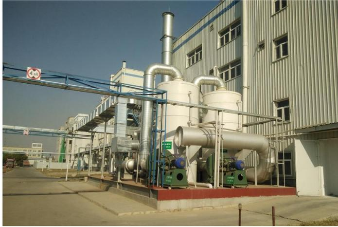
图：VOCs 处理装置
