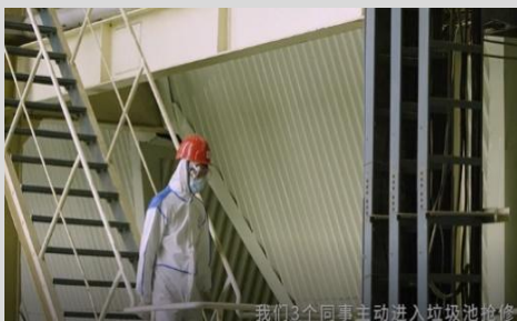
我们3个同事主动进入垃圾池检修 检修人员“全副武装”进行检修作业
