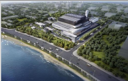
大连中新城区生活垃圾焚烧二期项目
