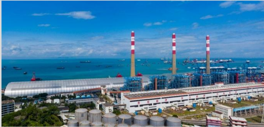
妈湾煤场封闭项目竣工
