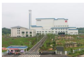
遂宁垃圾发电项目
