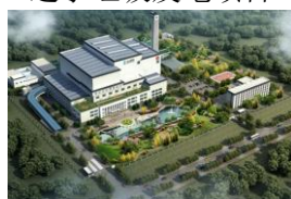
长垣垃圾发电项目（一期）
