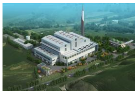
广安垃圾发电项目（一、二期）
