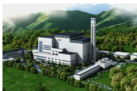
射洪垃圾发电项目
