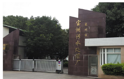
踏足环保领域 签订第一个生活污水处理项目协议——宝洲污水处理厂
