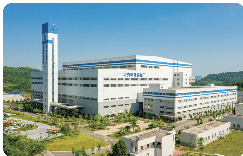
兴蓉环境下属再生能源公司万兴环保发电厂（一期）
