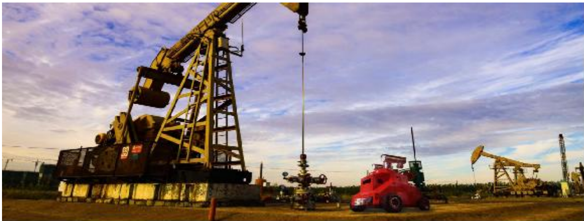
图四：油气巡检诊断解决方案
