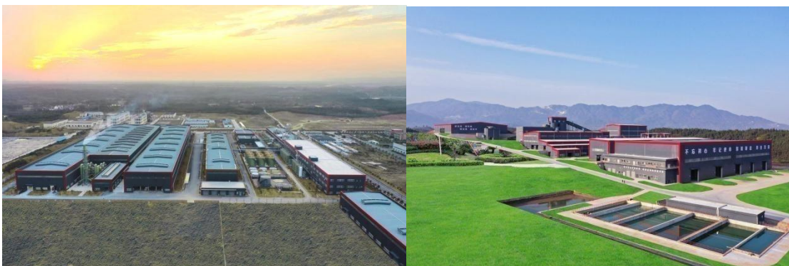
年产1万吨电池级碳酸锂项目及配套年产120万吨锂矿石高效综合利用项目
