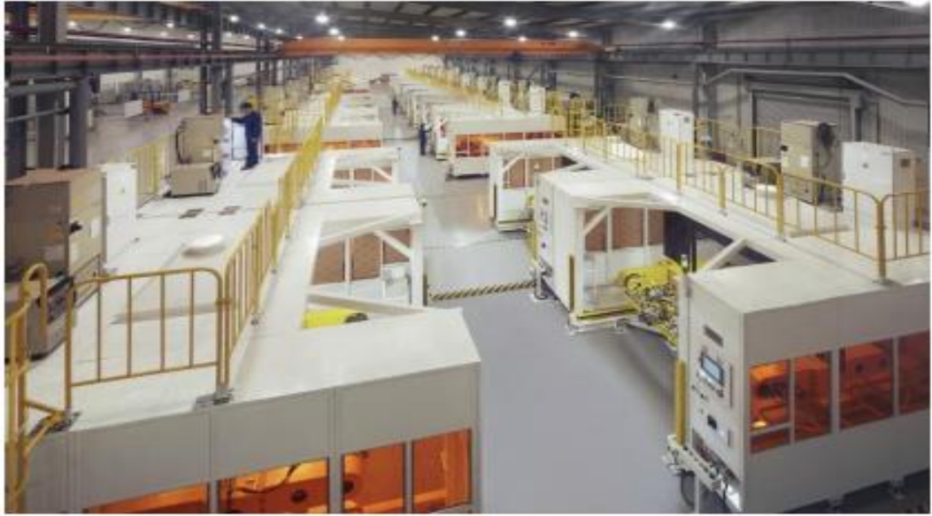
图：公司建造的摩托车焊装生产线
