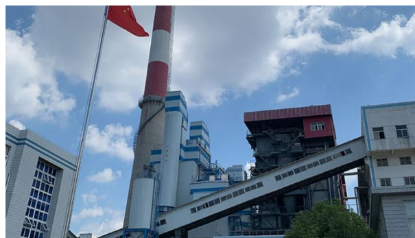
（合肥热电锅炉烟气 CCFB 脱硫脱硝除尘超净排放及脱白）
