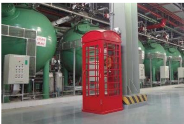
（三门核电凝结水精处理—世界首台 AP1000 机组）
