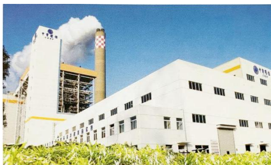
(常熟污泥干化耦合发电项目实景图)
