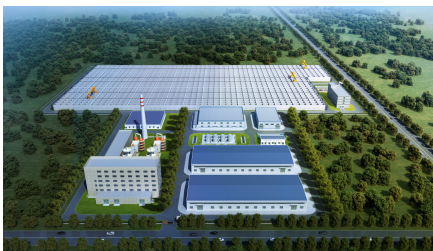
陈庄工业园固废处置中心项目
