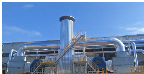
龙工（福建）机械公司喷涂车间VOCs治理改造项目
