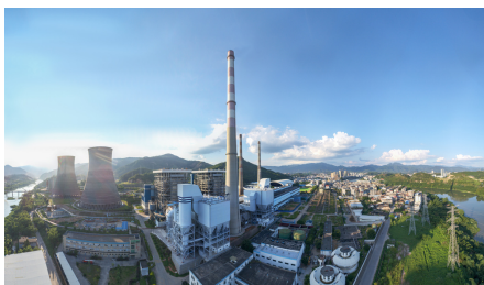
华电漳平2×300MW机组 “50355+053”干法超低排放治理工程
