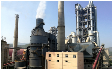
国内首个水泥万吨线脱硫超净排放 阳春海螺12000td脱硫除尘一体化工程
