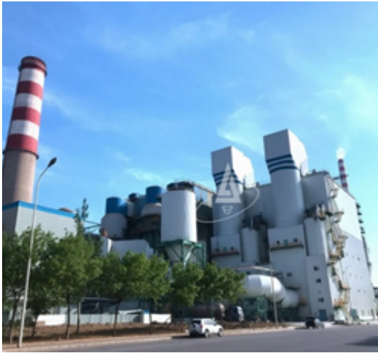
获奖技术应用于首钢京唐大型烧结项目
