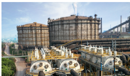
广西柳州钢铁一区3×120t转炉煤气 HLG干法深度净化与烟尘原位回用系统
