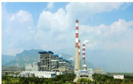
沁北电厂1000MW机组 余热利用低温电除尘器
