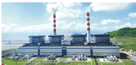
华能玉环电厂 4×1000MW 机组智慧环保示范工程
