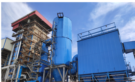
河南中科能源有限公司 热电联产项目环保岛EPC总承包项目
