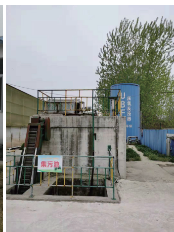
▲安欣牧业羊场污水处理厂厌氧反应器
