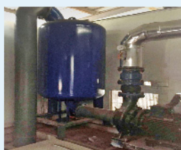
铁芯冷却塔节能供水系统改造完成图
