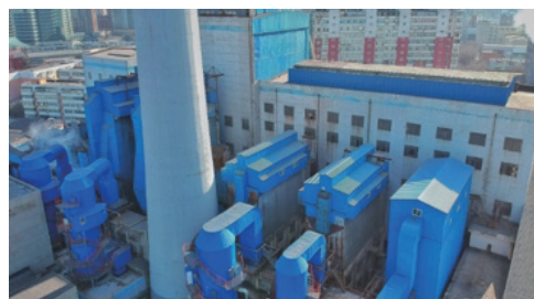
图:超低排放工程改造后全面
