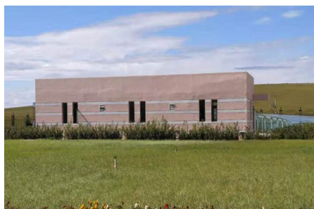
内蒙古矿业有限公司生活区污水处理站
