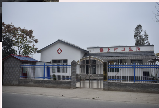
协助楼上村新建 120 余平方米的卫生室
