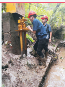
8月21日，南岸分公司员工抢险维修人员对南滨路等受灾区域的调压箱等燃气设施进行灾后检查维修。
