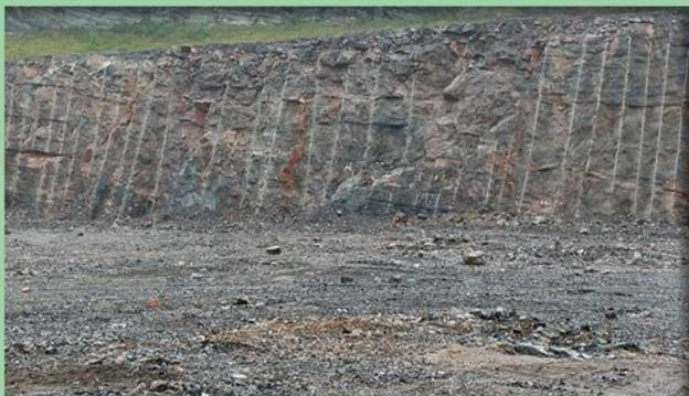
终了边坡实施预裂爆破维持岩体完整及稳定性
