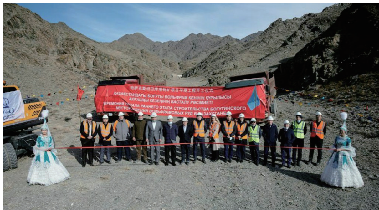
◆ 哈萨克斯坦巴库塔钨矿项目早期工程开工
