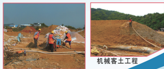
基质改良工程
