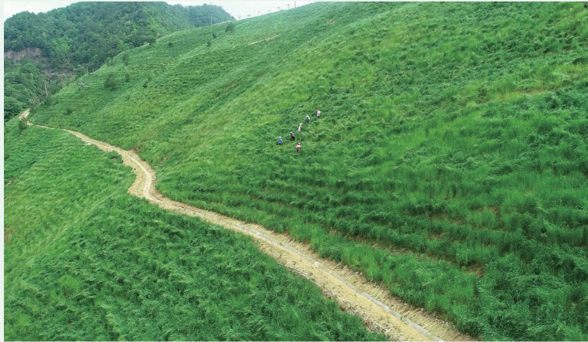
◆ 富家坞 500 标高排土场部分边坡生态恢复工程实施效果
