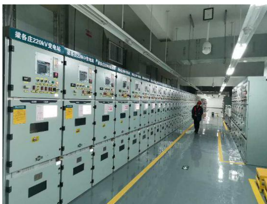
输变电工程高压开关柜
