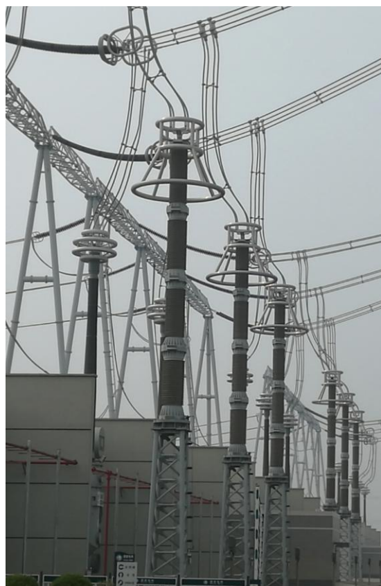
1000kV 复合外套避雷器潍坊站
