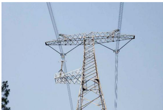
±800kV 直流线路型避雷器
