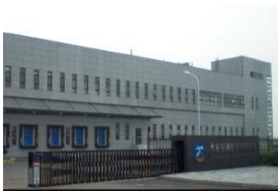
北京空港配餐楼冷库项目
