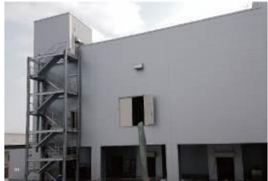
苏州长谷川厂房围护项目
