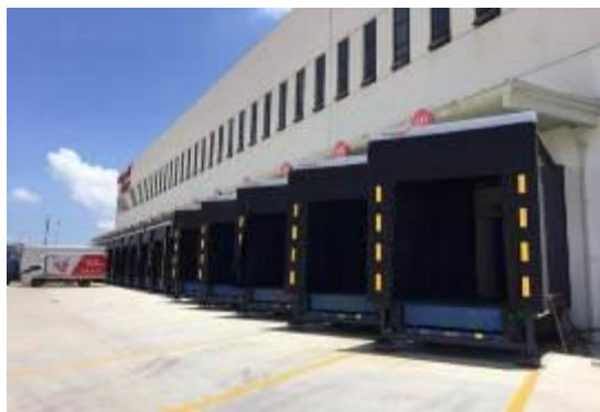
华润万家中山物流配送中心冷库项目
