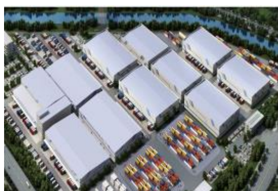
大连铁龙冷链物流项目
