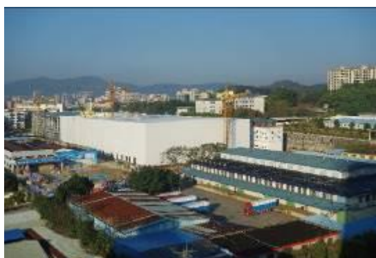
广州长运仓储冷库项目
