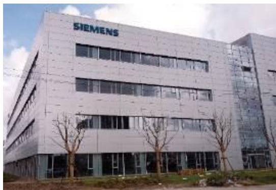
上海西门子厂房围护项目
