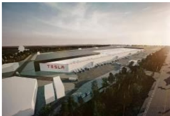
特斯拉上海超级工厂外墙板项目
