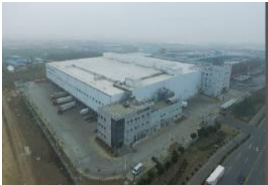
太古冷链物流（上海）冷库门项目
