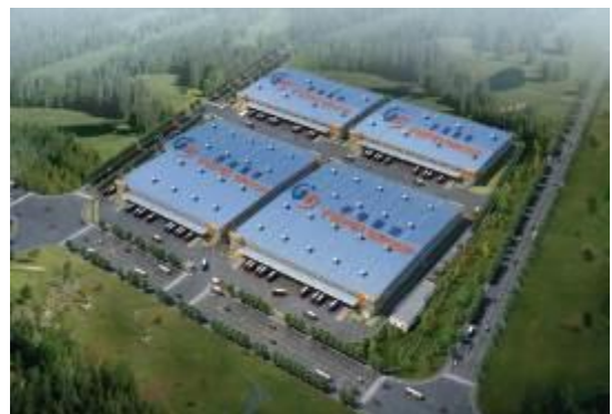
合肥肥东宇培物流园冷库项目
