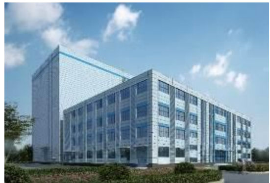
博瑞电力厂房外墙板项目
