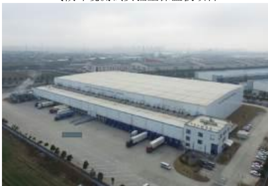
中外运普菲斯冷库（上海临港）项目
