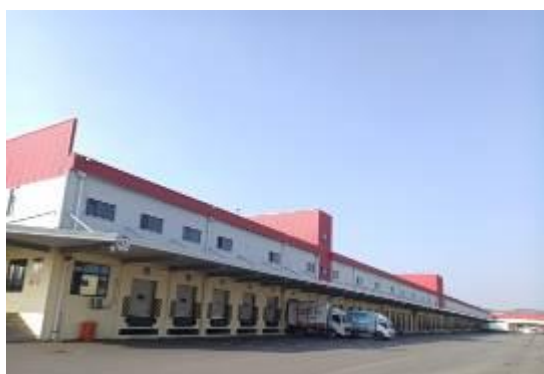
威海家家悦生鲜加工配送有限公司冷库项目
