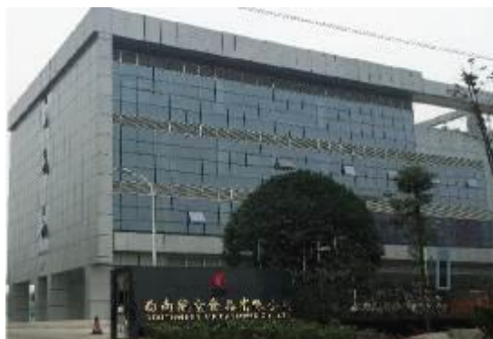
西南航空配餐楼冷库项目
