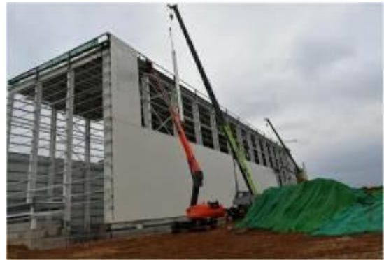
滇虹药业厂房外墙板项目
