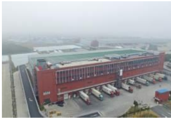
上海千隆物流有限公司冷库项目
