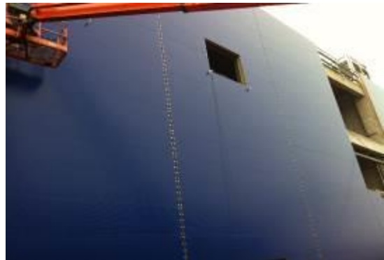
宜家家居（北京大兴）外墙板项目
