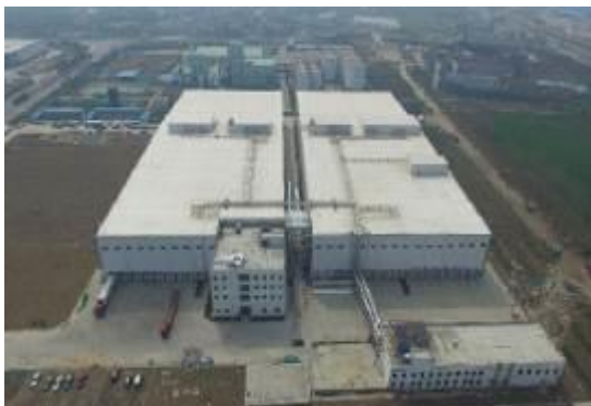
太古冷链物流（南京）冷库项目
