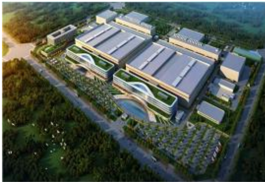
福建晋华存储器集成电路厂房外墙板项目
