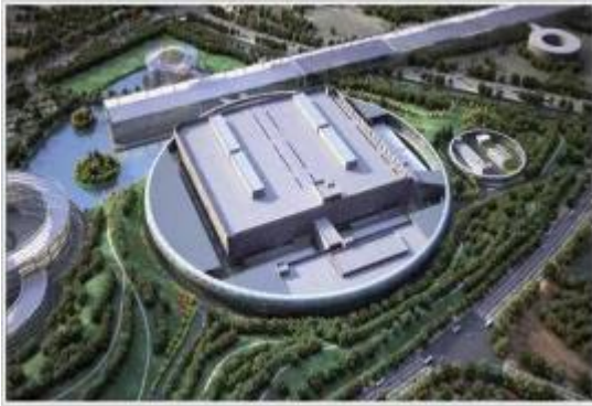
南京台积电晶圆厂外墙板项目
