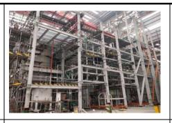
该装置为锂矿石加工工艺模块,模块布局紧凑,整体拼装精度要求高,装置划分为55个模块和16个模块辅助区域,整体拼装尺寸:58米\*30米\*23米,总重量约2,300吨。
