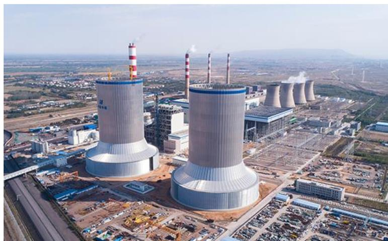
图 2：全钢结构间接空冷系统
