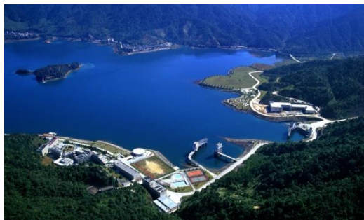
广州抽水蓄能电站项目
