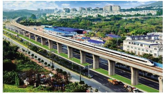
广佛肇城际轨道建设工程项目
