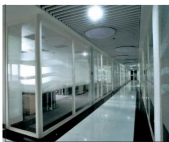
钢制防火玻璃门及隔墙
