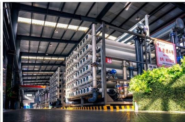
公司两大业务板块均建成循环水处理项目，其中，电力冶金化工板块于2016年底建成浓盐废水零排放资源化循环利用项目，日处理棋盘井工业园区高含盐废水10000吨，处理后的水达到国家工业循环冷却水处理标准（GB 50050-2007）及《城市污水再生利用工业用水水质（GB/T 19923-2005）中冷却用水标准，机械蒸汽再压缩（MVR）蒸发结晶系统产生的氯化钠和硫酸钠作为工业原料得到资源化利用，实现了高盐废水真正意义上的“零排放、资源化、循环利用”的可持续发展目标，并被纳入《内蒙古自治区节水与水污染防治先进技术指导目录（第三期）》。
