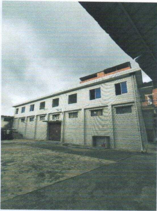
估价对象实勘照片
