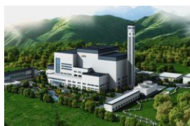
射洪垃圾发电项目
