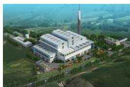
广安垃圾发电项目（一、二期）
