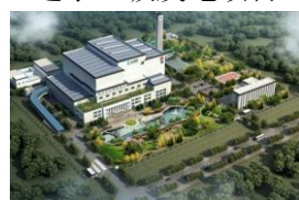
长垣垃圾发电项目（一、二期）
