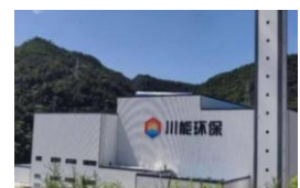
古叙垃圾发电项目
