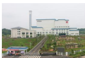
遂宁垃圾发电项目
