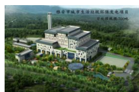
雅安垃圾发电项目（一、二期）
