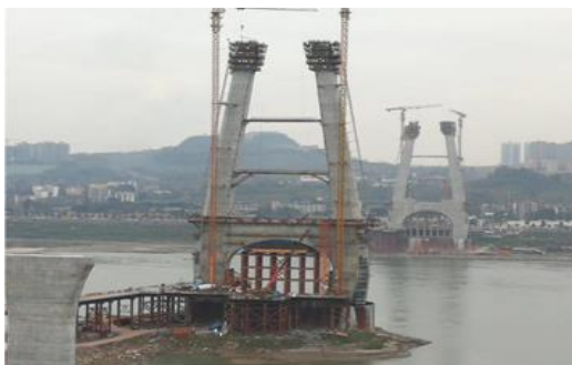
轨道交通4号线二期工程质量检测
