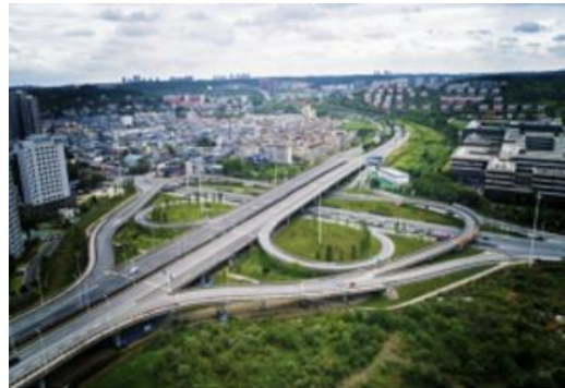
重庆市李家花园隧道改造工程
