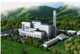
射洪垃圾发电项目
