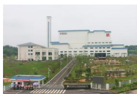
遂宁垃圾发电项目
