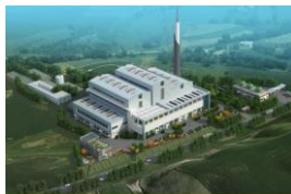
广安垃圾发电项目（一、二期）
