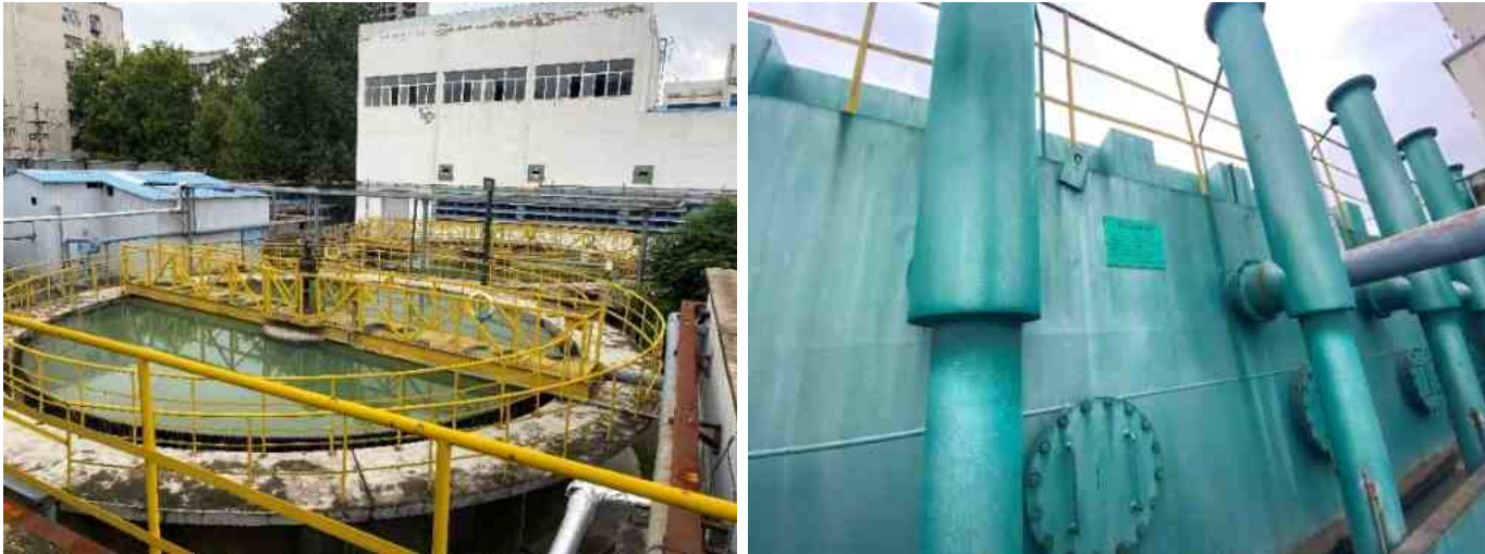
污水处理设施
