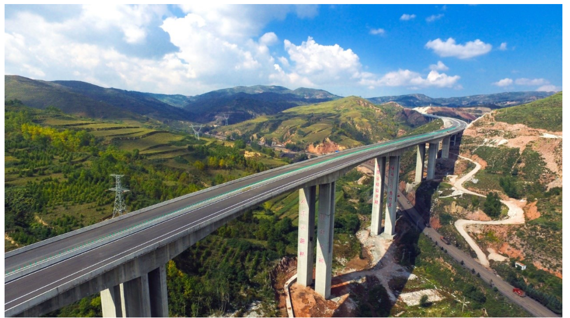
灵河高速公路原平至神池段路基、桥隧、采空区工程施工第 LJ5 标段
