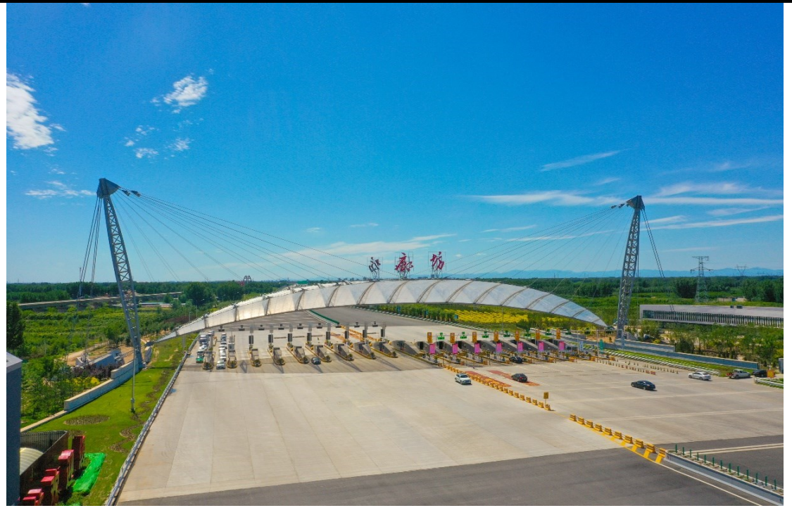
新机场北线高速公路廊坊段
