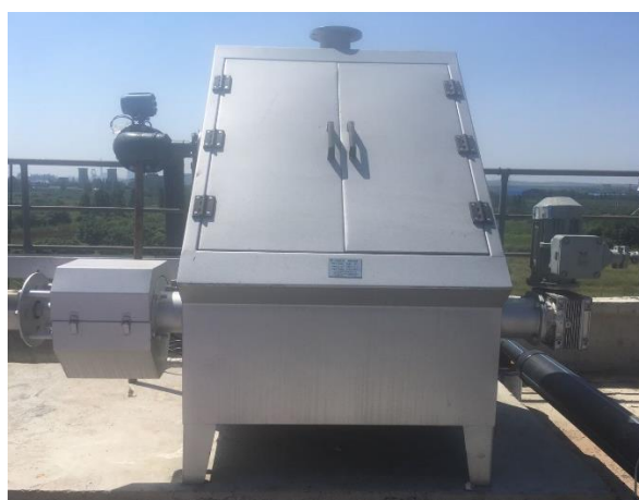
固液分离一体化除渣机设备实图
