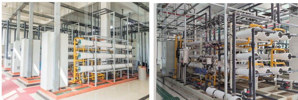
反渗透膜集成装置设备实图
