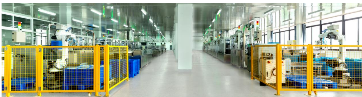
公司碱性电池智能化生产车间总体视图
