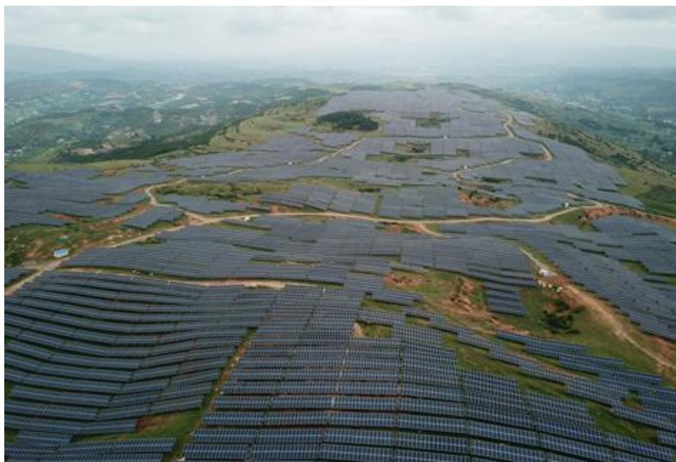
贵州省威宁县斗古瓦厂120MWp农业光伏电站
