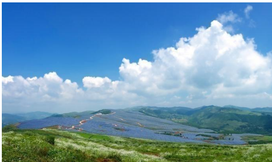
贵州省威宁县么站60MWp农业光伏电站项目
