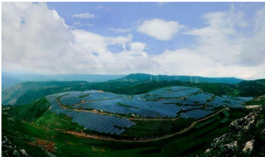
贵州省威宁县平箐30MWp光伏电站项目
