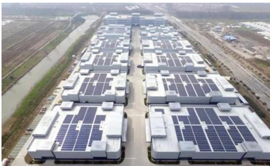
上海临港弘博新能源发展有限公司分布式光伏发电项目
