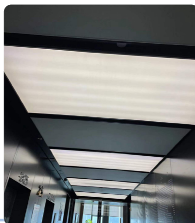
◆ 使用 LED 感应灯管节约能耗
