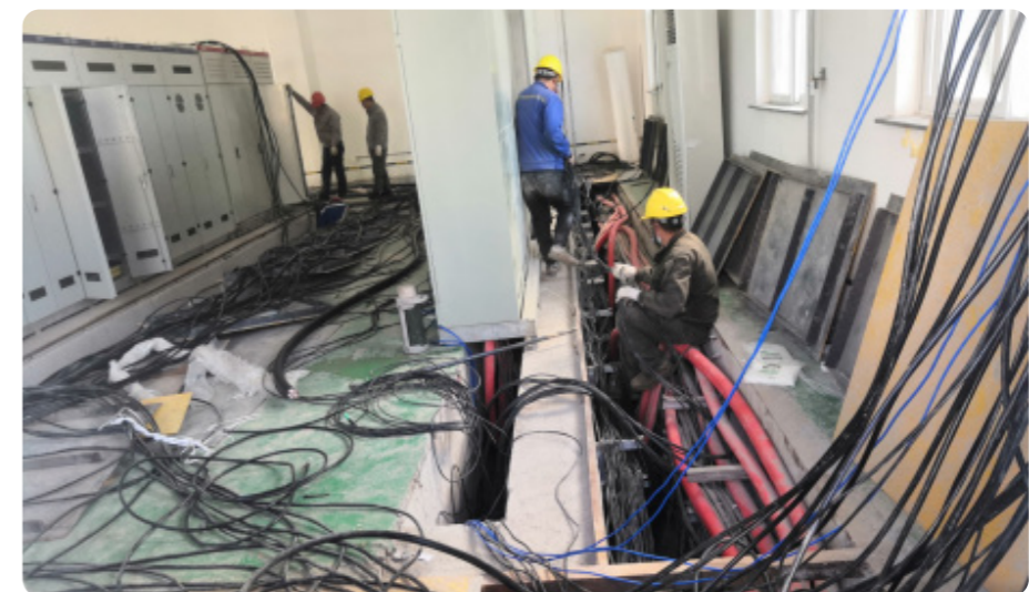
◆ 惠民垃圾焚烧发电厂水系统改造过程
