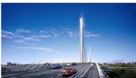
图例：上海浏港大桥
