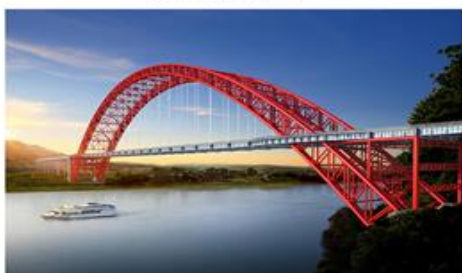
图例：四川犍为岷江大桥
