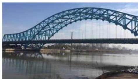
图例：泗阳城子河公路大桥
