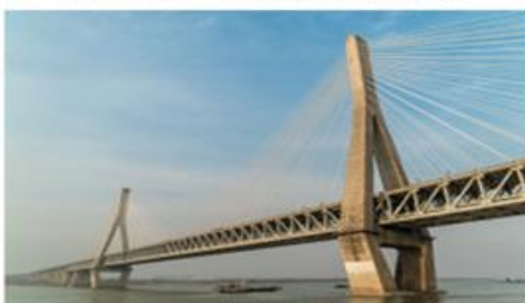
图例：天兴洲长江大桥
