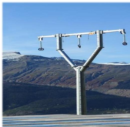
(3) 变电站构架：变电站是电力系统中变换电压、接受和分配电能、控制电力的流向和调整电压的电力设施，它通过其变压器将各级电压的电网联系起来。在电力系统中，变电站是输电和配电的集结点。因此，变电站整体构架的性能直接影响到变电站工作效率。变电站构架主要有角钢、钢管、钢板等钢材组成，构件之间通过焊接或者螺栓连接，构架连接节点比较复杂，一般采用柱头形式或者法兰形式，要求外观美观，广泛应用于变电站内各种设备和导线之间的支撑功能。
