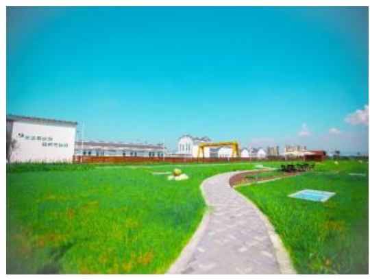
安徽望江污水处理厂项目扩建工程（5万吨/日）
