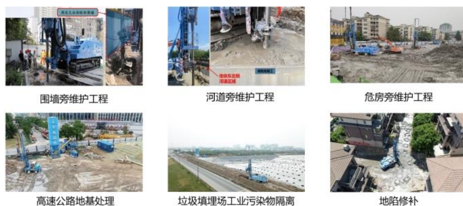
图注 17：不同场景的地下维修维护工程
